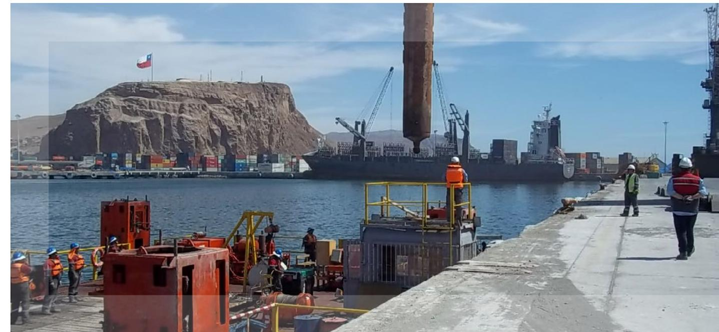
A través de la profundización de los sitios 4 y 5, se aumentó el calado de 10 metros a 11,4 metros. Las obras consideraron la aplicación de un innovador sistema de mantas geotextiles en el fondo marino para su estabilización, tras practicar el retiro de material sólido en la profundidad.
