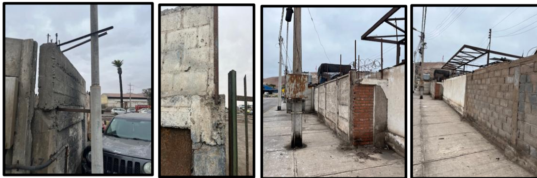
Imagen Muros existentes.
