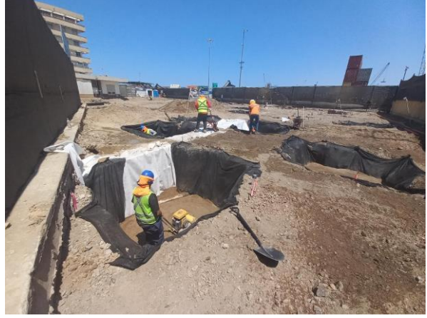
Ilustración 36. Muro cubierto con geotextil Fuente: Rolando Ajata.
