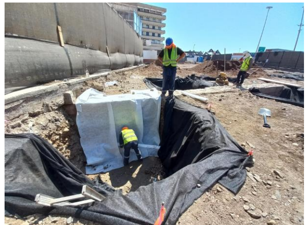
Ilustración 34. Muro cubierto con geotextil Fuente: Rolando Ajata.
