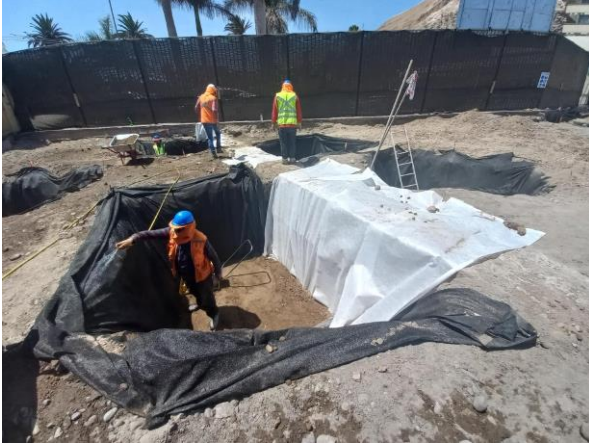
Ilustración 35. Muro cubierto con geotextil Fuente: Rolando Ajata.
