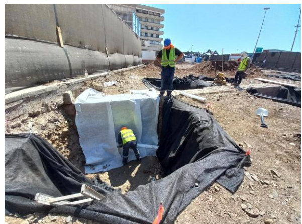
Ilustración 34. Muro cubierto con geotextil Fuente: Rolando Ajata.
