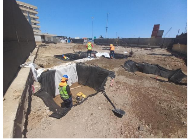
Ilustración 36. Muro cubierto con geotextil Fuente: Rolando Ajata.
