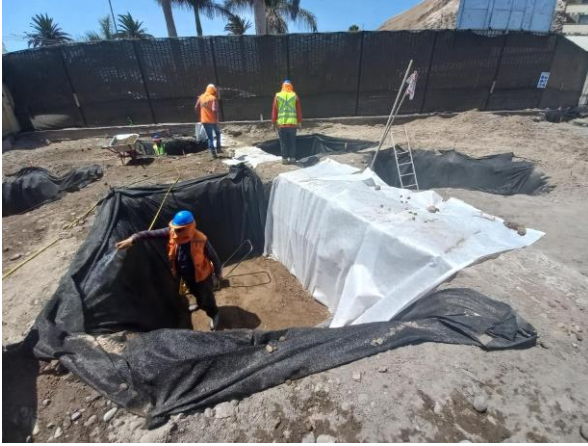
Ilustración 35. Muro cubierto con geotextil Fuente: Rolando Ajata.
