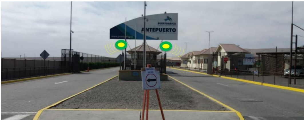
Acceso principal del antepuerto, ubicación referencial de antenas RFID
