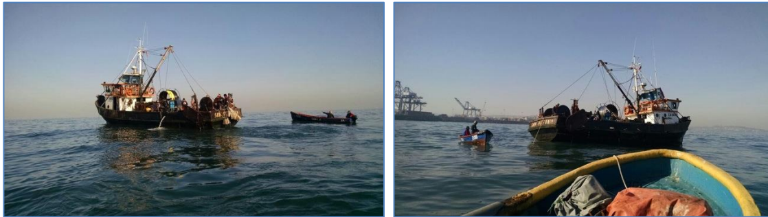
Figura 5. Instalación del cable desde embarcación.
