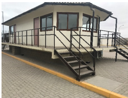
Imagen: Barandas y escaleras del Edificio de Control de Acceso.
