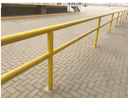
Imagen: Barandas (2) peatonales acceso interior Zona de Respaldo.
