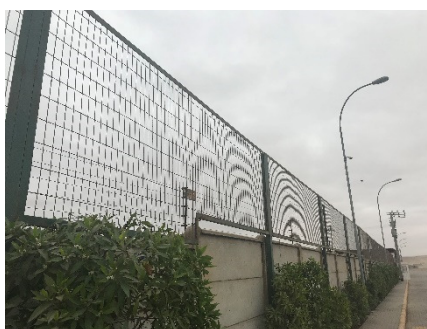
Imagen: Rejas perimetrales verdes de la Zona de Respaldo.
