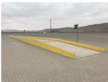
Muros a pintar bascula
