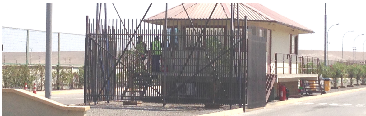
Imagen 8: Rejas y Portones de Acceso y Salida de Antepuerto.
