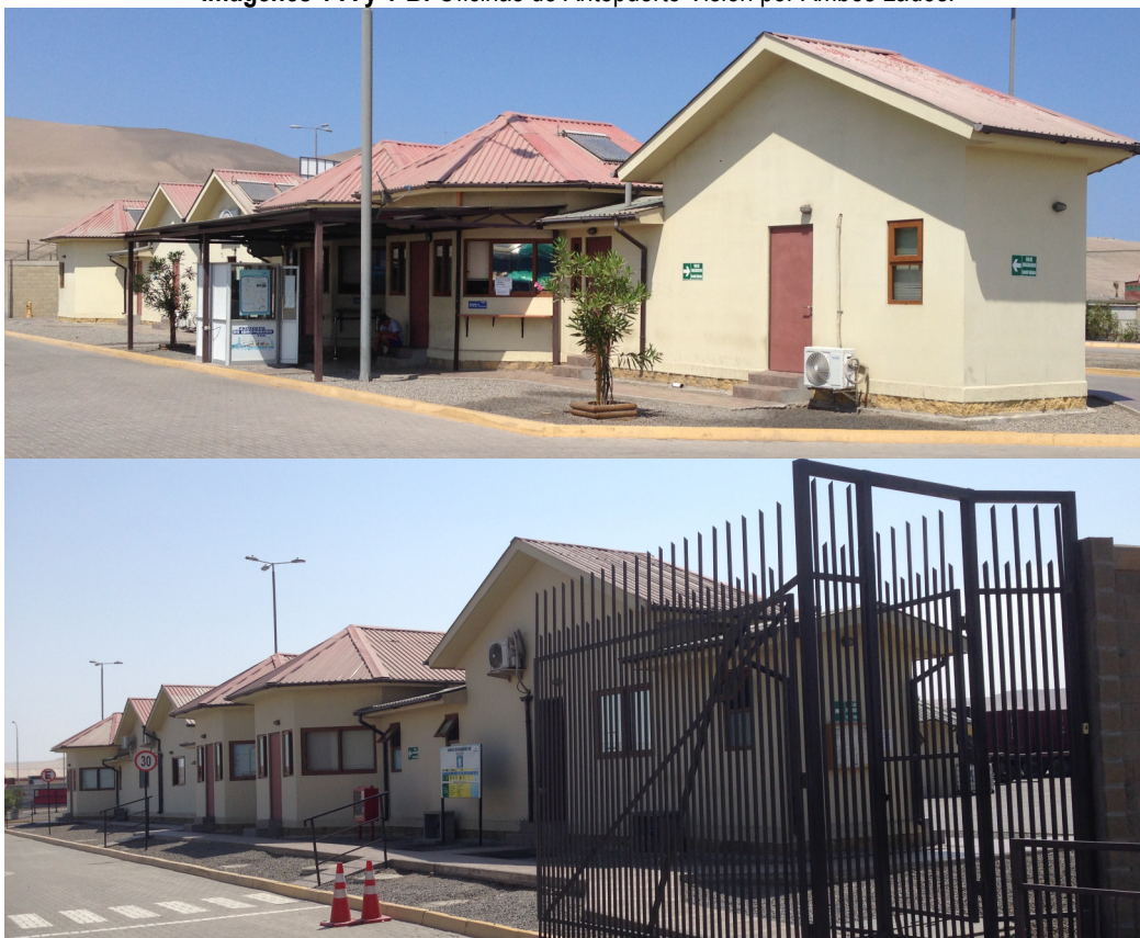
Imágenes 1-A y 1-B: Oficinas de Antepuerto Visión por Ambos Lados.
