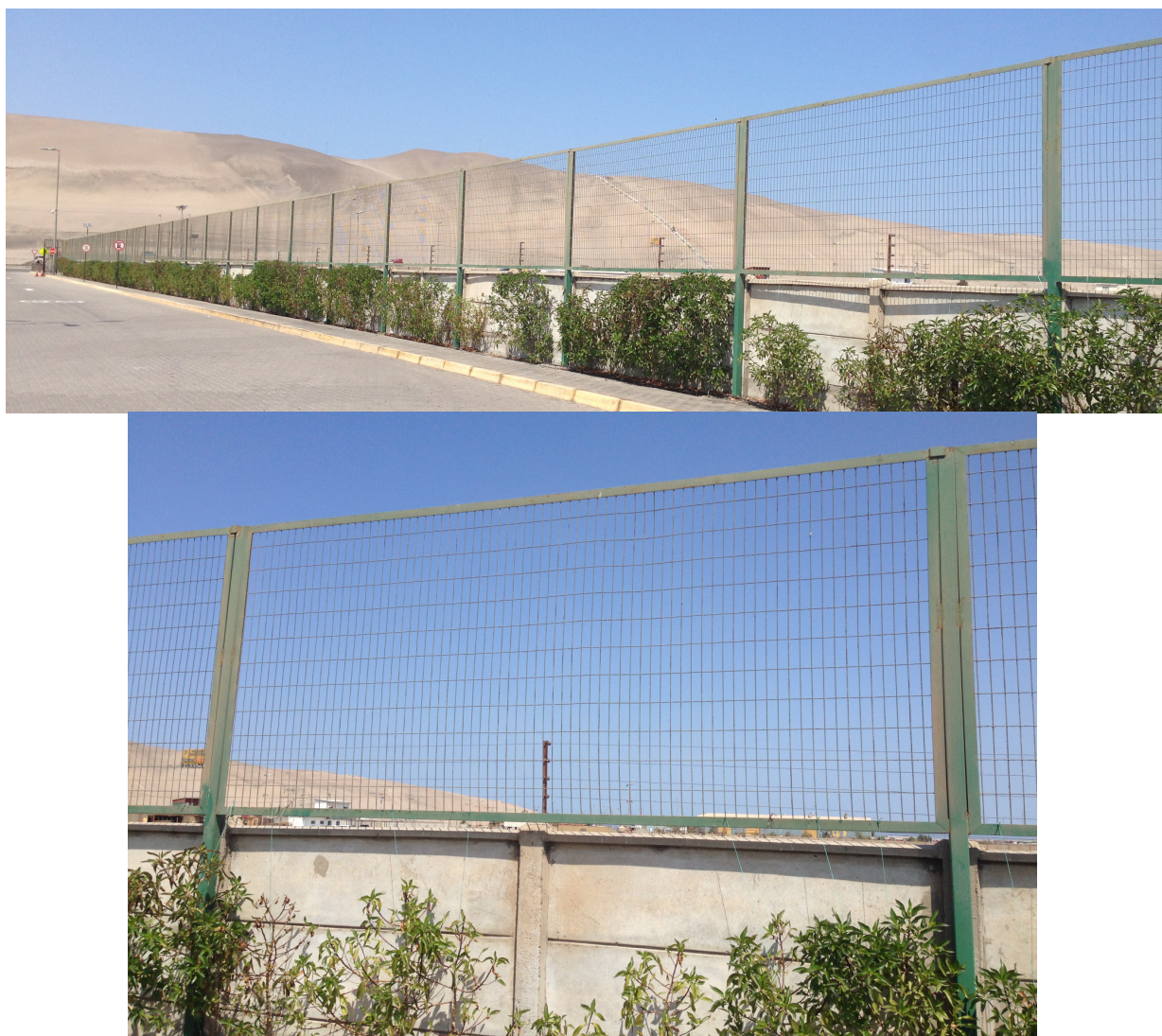
Imágenes 9-A y 9-B: Rejas Perimetrales Verdes de Antepuerto.
