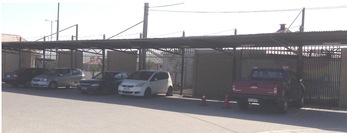
Imagen 5: Sombreadores Estacionamiento de EPA y Rejas de Antepuerto.
