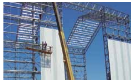
Construcción / Dique Asmar / Talcahuano - Chile
