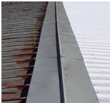
Aplicación de PVC Industrial / Antes y después
